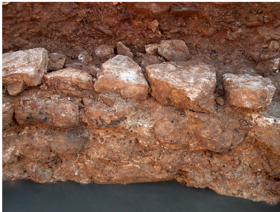
Fig. 3. Particolare della tessitura di rivestimento in pietre refrattarie della calcara.
