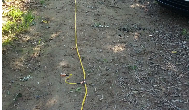
Figura 5. Picchetto in ferro infisso nel terreno e collegato con morsetti ai cavi elettrici.
