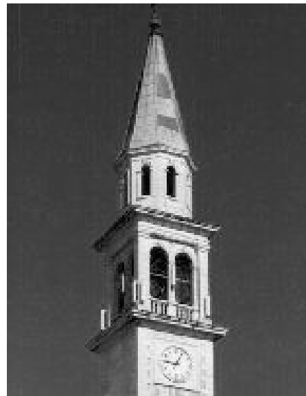
Fig. 11) - Esempio di installazione mimetica.
