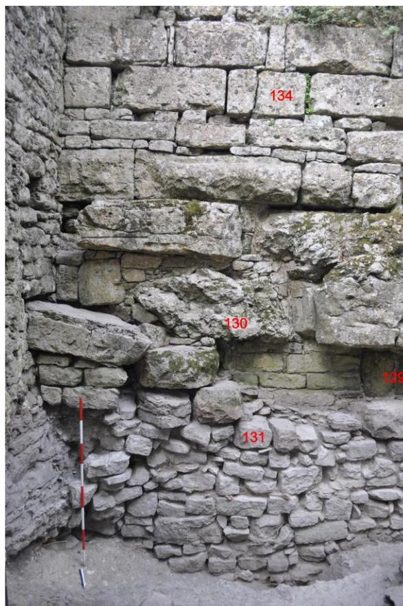
Fig. 13. Torre 9, saggio 5: muro nord e fondazione.
