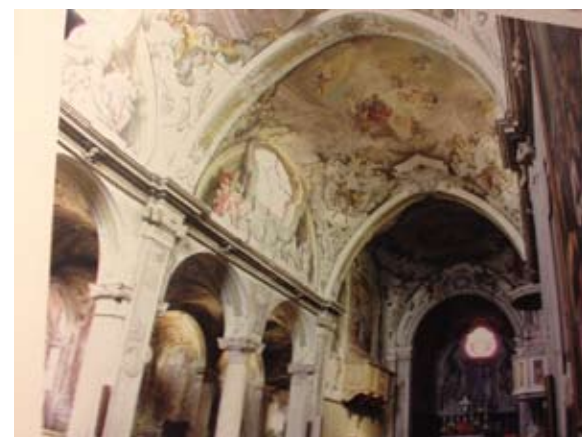
Fig. 11. San Nicolò di Rodengo Saiano; veduta della navata.
