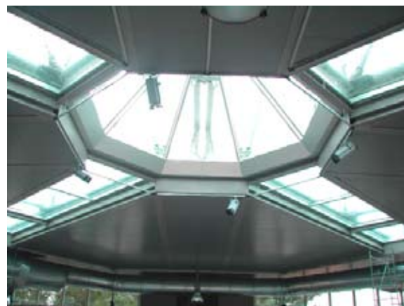
Fig.6- Vista interna dal basso della copertura dell'autosalone CoBraMa
