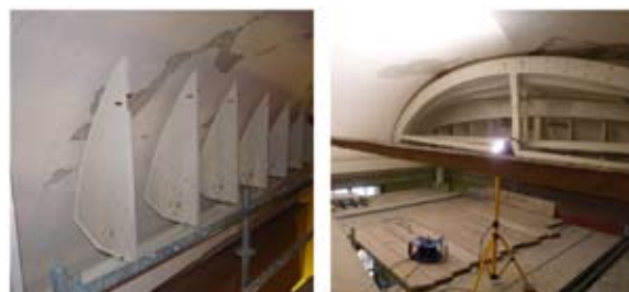
Fig. 16 Casi studio: B - Imola: la trave di cordolo perimetrale
