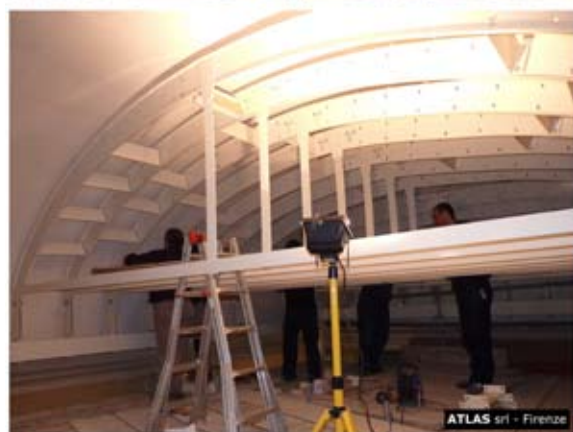
Fig. 17 Casi studio: B - Imola: fasi costruttive di posizionamento delle cinte
