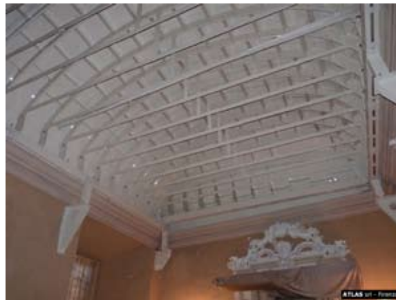
Fig. 8 Casi studio: B - Imola: vista di insieme della struttura realizzata
