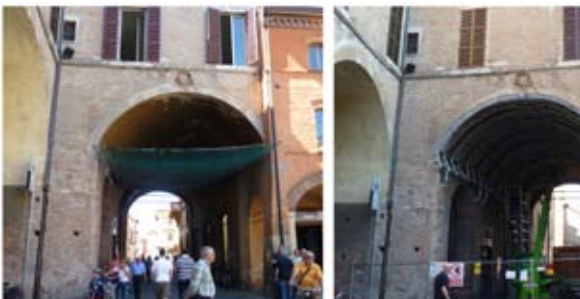
Fig. 18 Esempio di sistema di puntellamento evoluto impiegato in esterno a protezione di eventuali distacchi di intonaco - Imola volta palazzo comunale. Prima e dopo l'intervento: la rete esistente viene sostituita da un sistema di centine
