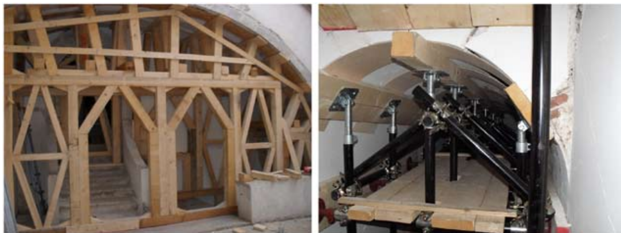
Fig. 1 - Puntellamenti in elementi lignei e legno/metallo - (Fonte: www.innovazionerestauro.it )
