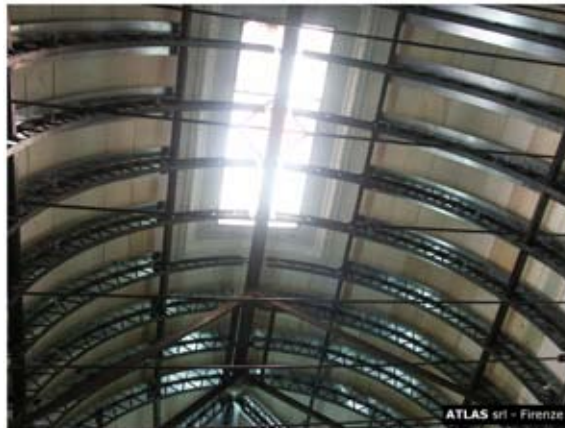
Fig. 14 Casi studio: A - Cecina: fasi costruttive della realizzazione della struttura
