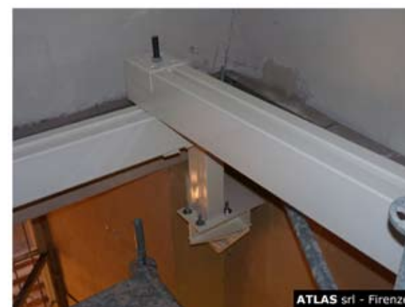
Fig. 16 Casi studio: B - Imola: la trave di cordolo perimetrale
