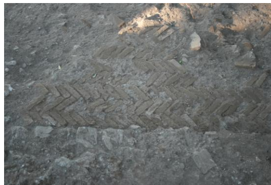
Fig. 19. Particolare della pavimentazione in opus spicatum dell’Ambiente VII.
