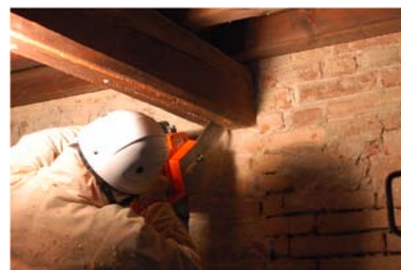
Fig. 16 Fasi operative per consolidamento mediante l'utilizzo di lamine metalliche.
