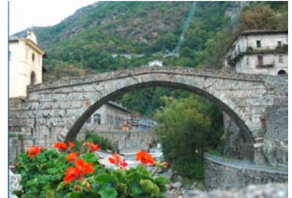
Fig. 12 Il Pont Saint Martin ad Ivrea.
