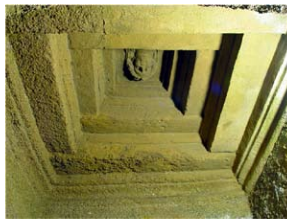
Fig. 5 Ipogeo dei Volumni, Perugia, età ellenistica. Rappresentazione di cupola di legno "a filari aggettanti".
