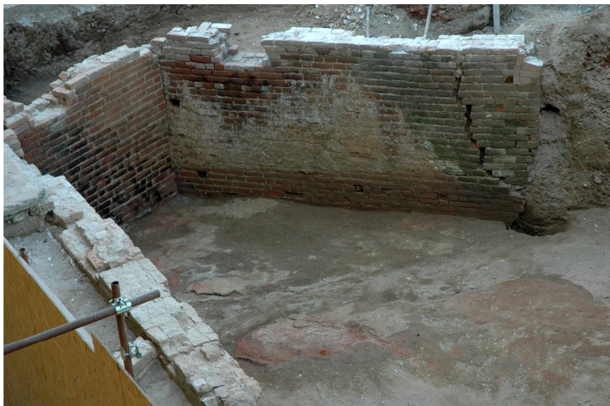
Fig. 3. Morimondo, cortile occidentale dell'abbazia. Testa del muro 2 (in primo piano), muro 5 e muro 4.
