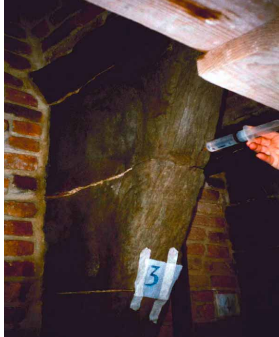
Figura 17: consolidamento della pietra.
