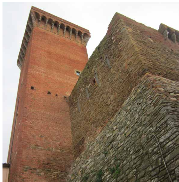
Figura 23: complesso Torre – Rocca - Cassero restaurato.
