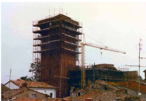
Figura 9: ponteggi installati attorno alla Torre.
