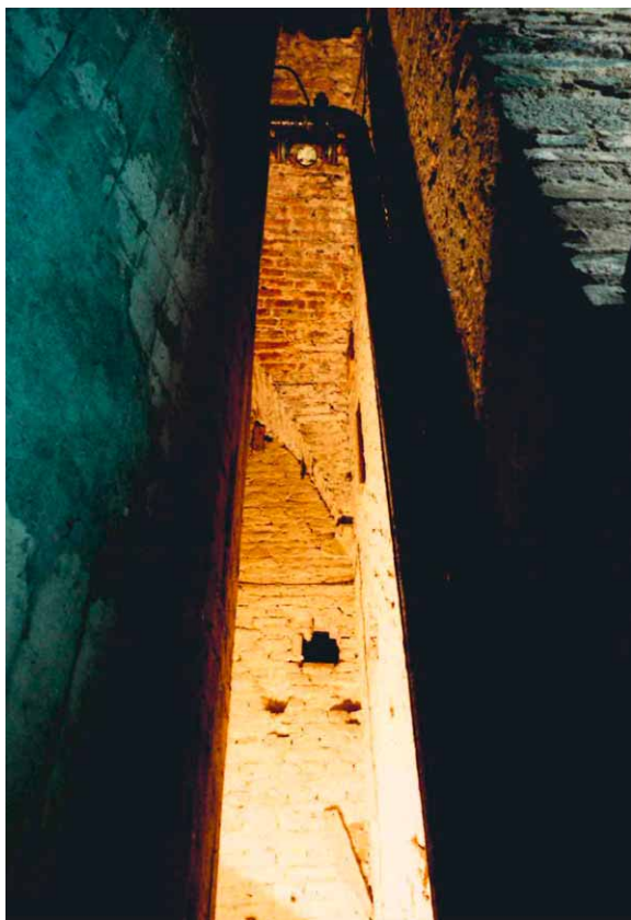
Figura 8: è visibile la cisterna in c.a. e la parete interna della Torre.
