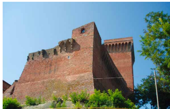
Figura 40: veduta del Castello di Marciano (AR) a seguito dei lavori di restauro.
