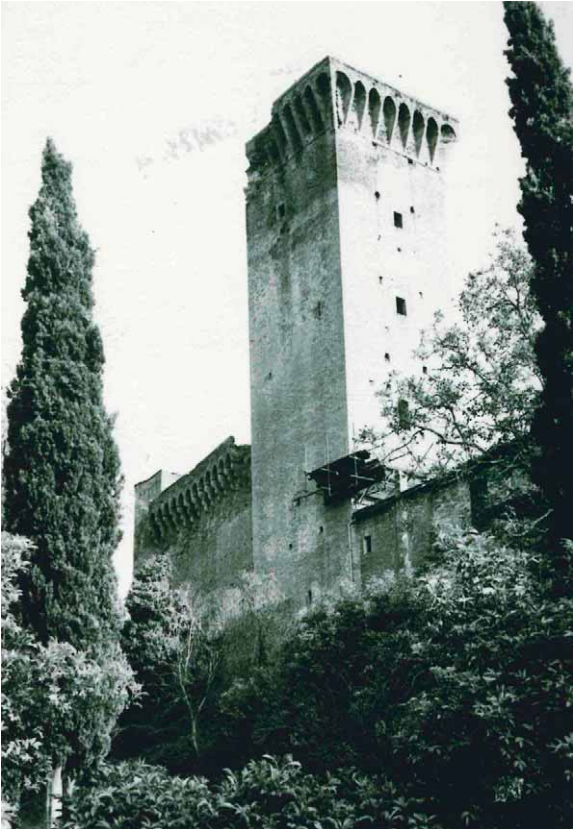
Figura 2: stato di conservazione della Torre anni '80, prima degli interventi di restauro.
