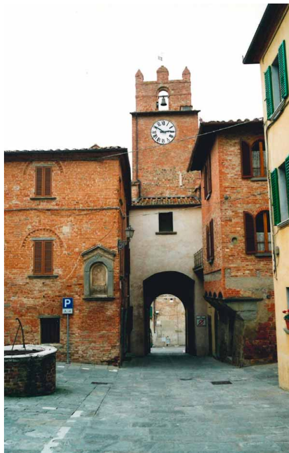
Figura 38: veduta della Porta d'accesso dall'interno del Castello dopo il restauro.
