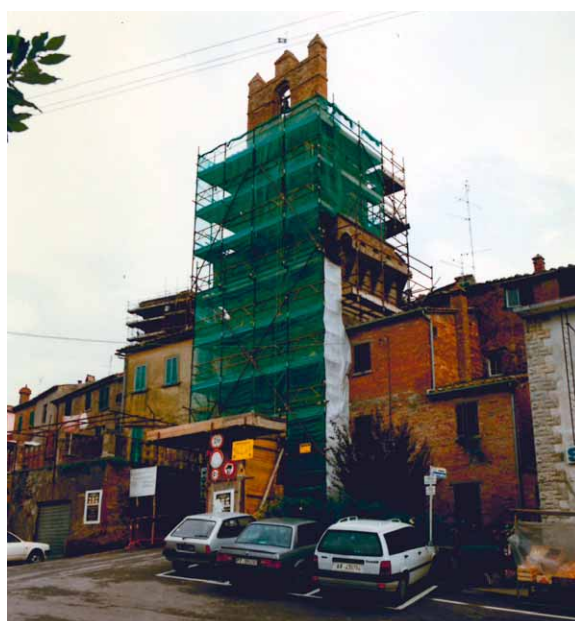
Figura 31: ponteggi alla Porta d'accesso.
