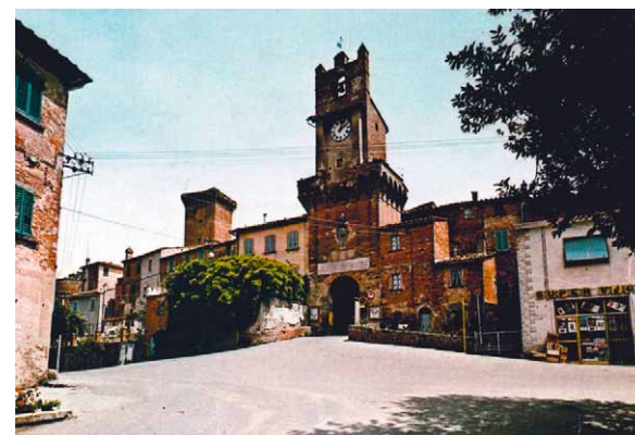
Figura 25: veduta d'insieme della Porta d'accesso e di parte delle mura prima del restauro.
