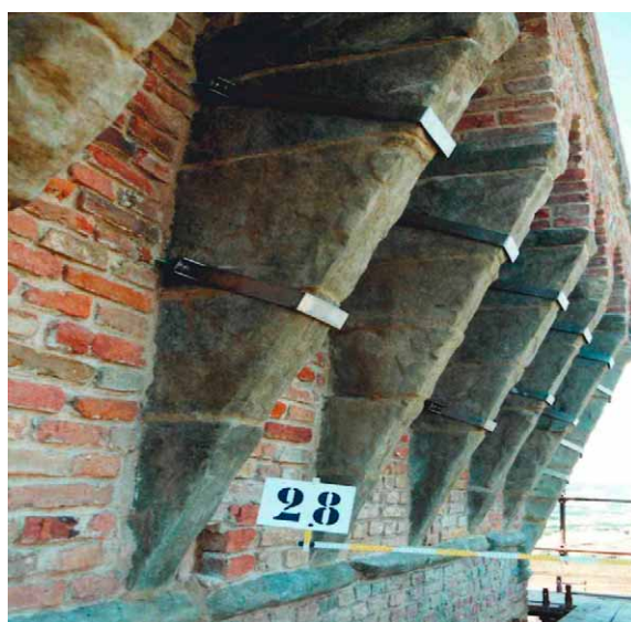
Figura 20: beccatelli a restauro ultimato.
