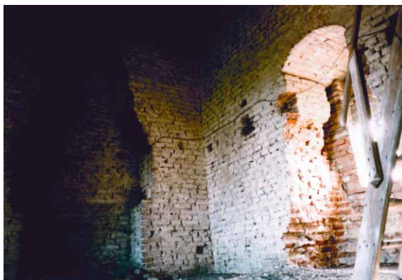
Figura 5: interno della Torre, prima degli interventi di restauro, ambiente con solaio in legno.
