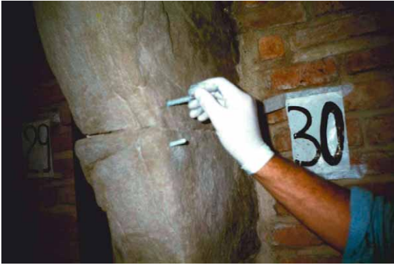
Figura 15: intervento di restauro dei beccatelli tramite l'utilizzo di barrette in vetro resina.
