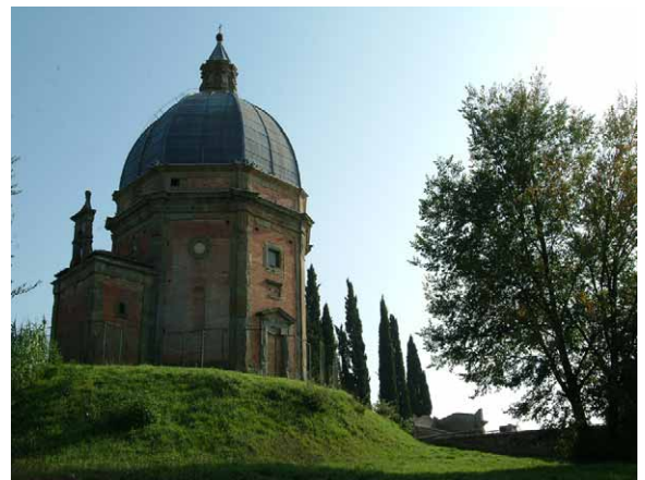
Figura 49: Tempietto della Vittoria su disegno di Giorgio Vasari, Pozzo della Chiana (AR).
