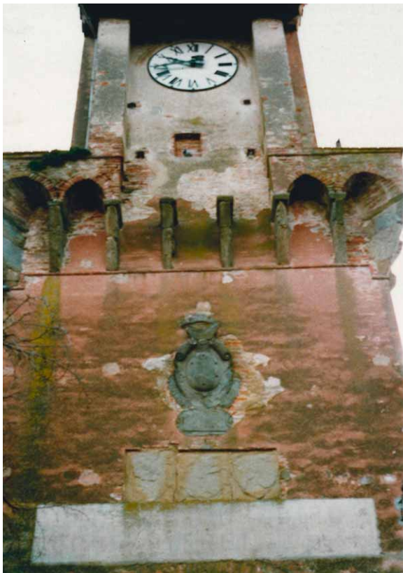
Figura 26: particolare dello stemma mediceo e della torre dell'orologio sulla Porta d'accesso prima del restauro.
