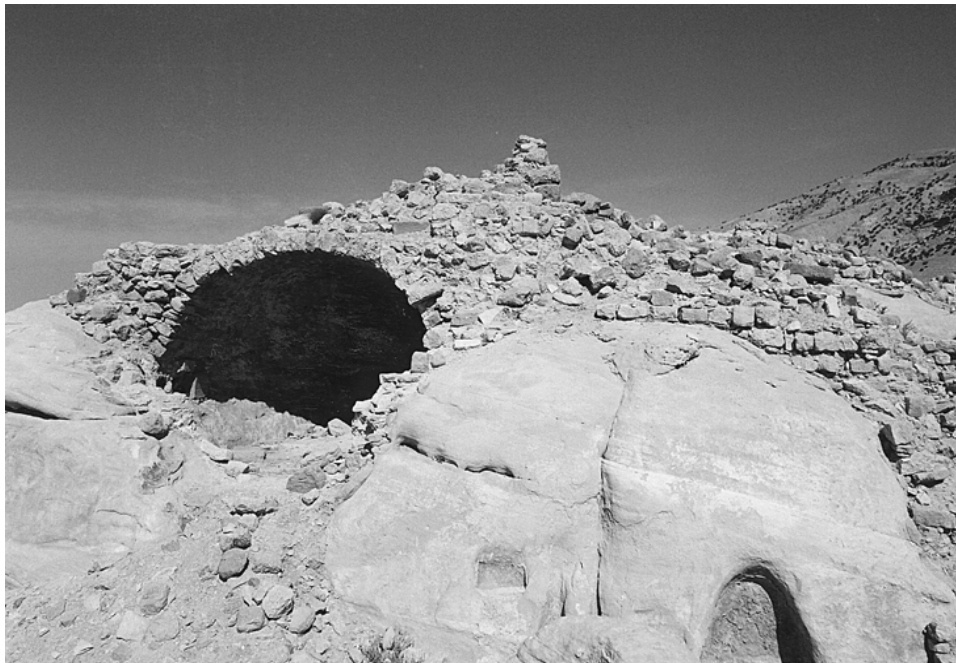
Fig. 6 – Wu'ayra: cisterna costruita in muratura con copertura voltata e presa d'acqua superiore relativa al primo impianto castellano.
