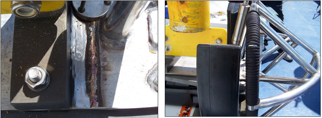
Fig. 5 – Saldatura effettuata sulla piastra per allungarla (a sinistra) e conseguente allontanamento della gabbia di protezione dai trasduttori (destra).
