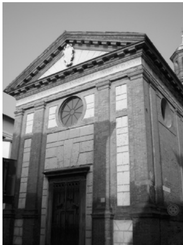
Fig. 6 - Facciata principale di Santa Margherita, Cremona. Foto Faliva.
