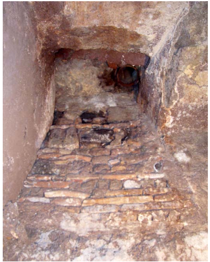
Fig. 16. Ambiente O, fognolo all'interno dell'apertura a bocca di lupo.
