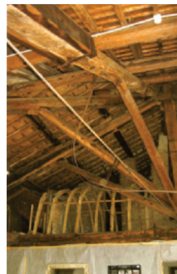
Fig. 2 - Restauro delle coperture e recupero conservativo del Belvedere. La capriata principale dopo l'intervento di restauro e consolidamento statico.
