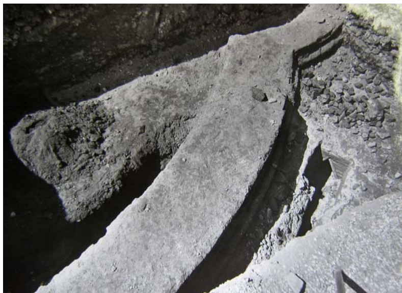
Fig. 43. Domus in proprietà ACEA. Scavi del Comune di Roma 1953-1955: struttura polilobata (archivio X Rip., Neg. inv. n. 13580).
