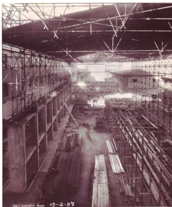
Figura 17 – Cantiere, vista fotografica della fase di edificazione del salone interno (Archivio CRF)
