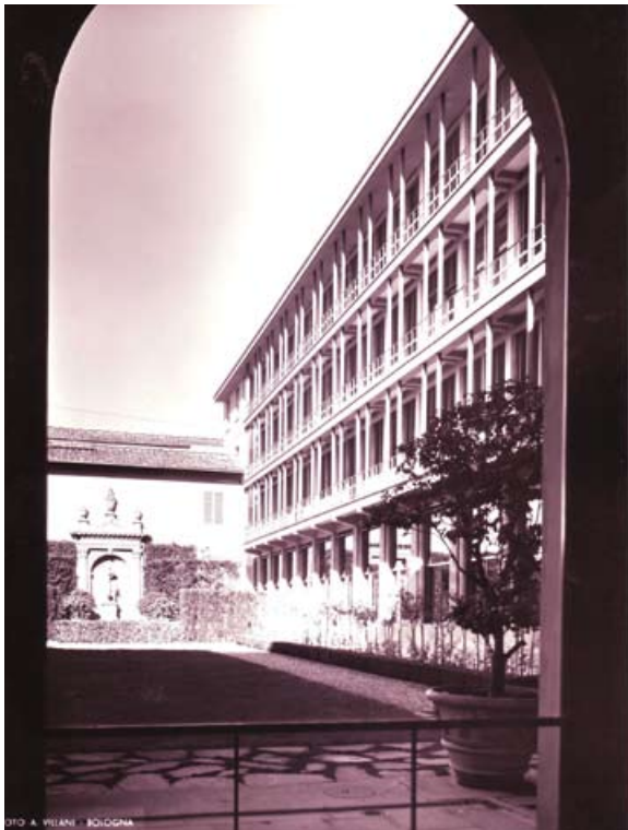
Figura 12 – Vista fotografica della facciata lato giardino (Archivio CRF)
