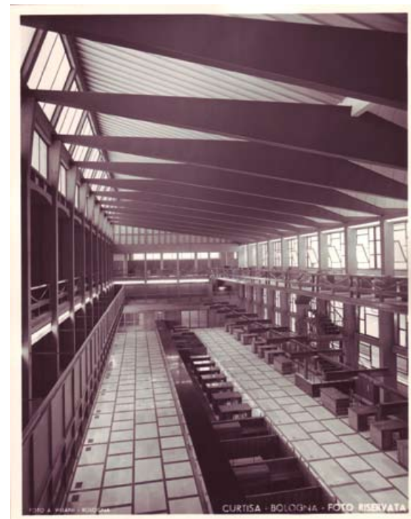
Figura 4 – Vista fotografica del salone interno (Archivio CRF)
