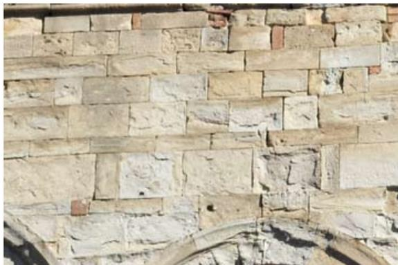
**Fig. 3** Particolare del paramento murario della pieve di San Verano a Peccioli
