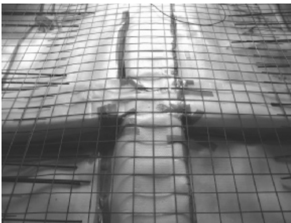
Fig. 11 - L'estradosso della volta è rivestito dallo strato soffice in attesa del getto.
