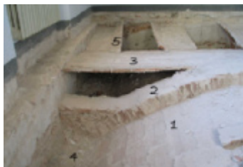
Fig. 3 - L'estradosso durante lo smontaggio delle lunette.
