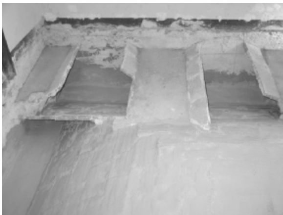
Fig. 10 - L'estradosso del padiglione messo a nudo viene rinforzato con GFRP così come pure l'estradosso delle lunette e delle unghie, una volta rimontate.
