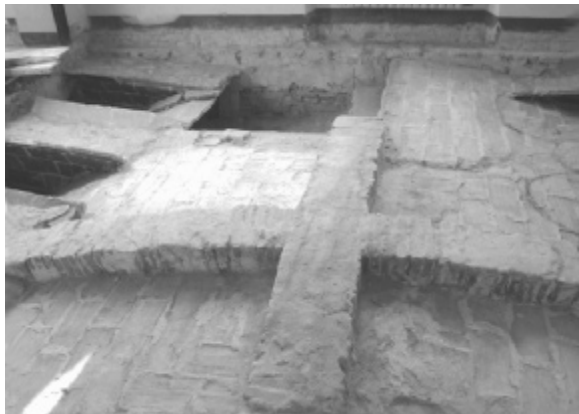
Fig. 9 - Dopo l'asportazione del pavimento e del materiale di riempimento, vengono smontate le lunette e le unghie di estremità.
