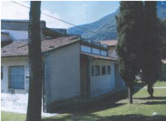
Figura 4 - Foto lato nord-ovest
