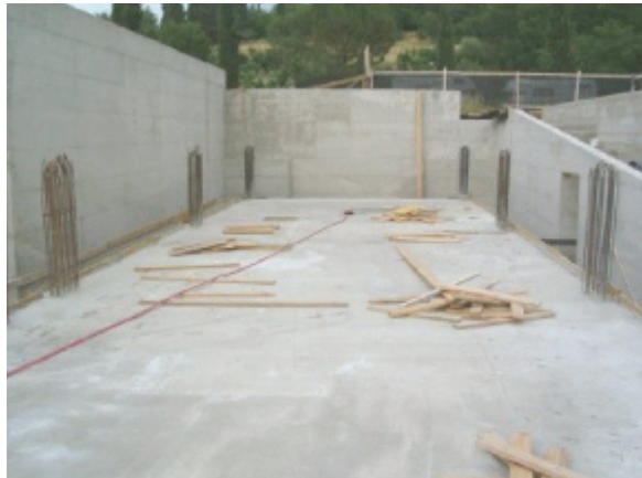
Figura 13. Superficie dell'impalcato mobile.
