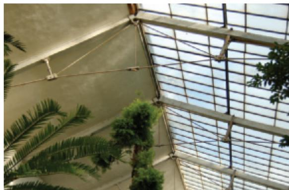
Fig. 6 - Capriate di tipo Polonceau in una delle serre dell'Orto Botanico di Firenze.
