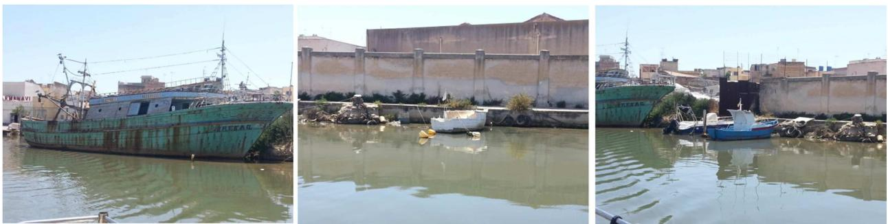
**Figura 10 – Parte interna del canale del Porto di Mazara in cui si può notare come le barche poggino sul fondale a causa di un insabbiamento del canale stesso.**
